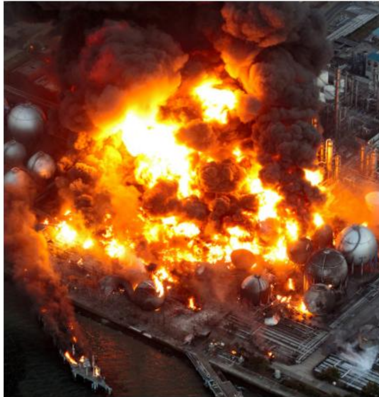
炎を上げて燃えるコスモ石油千葉製油所 = 2011年3月11日午後5時36分、千葉県市原市、本社ヘリから
